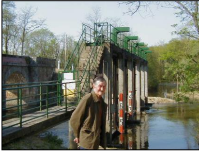
Alfred Chocteau La modification de l'hydraulique du Lac p. 86 à 89 du 2003 à 2005
