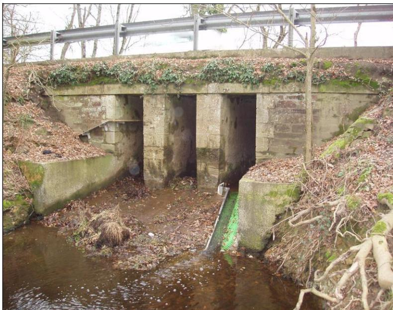
Passage de la « maison blanche » à St Mars de Coutais sous la chaussée de Bouaye, avec la passe à loutres dans la voie de gauche et la passe à civelles dans la voie de droite.
